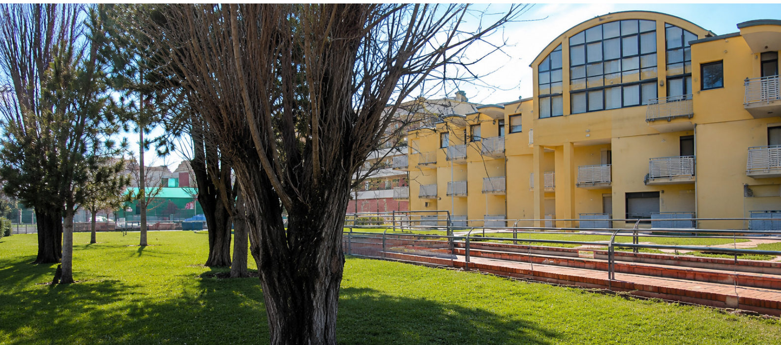
Struttura Arcobaleno - CSA F.F. Casson, Chioggia
